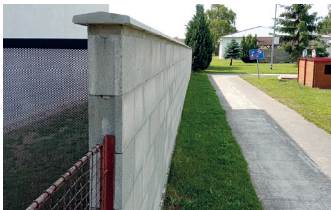
Obec Kúty zrealizovala vybudovanie oplotenia v areáli MŠ
